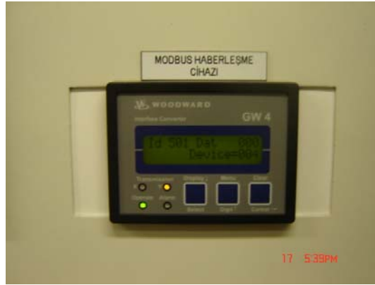
Şekil 3.11: GW4 CANBUS\MODBUS Çevirici
