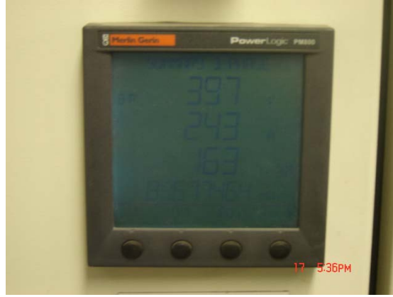
Şekil 3.4: PM800 Enerji Analizörü
