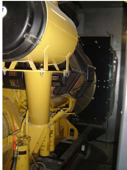
Şekil 3.15: CAT Dizel Generatör
