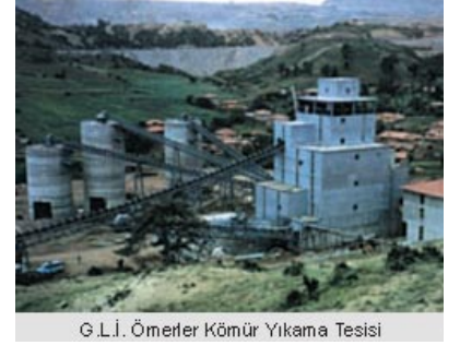
G.L.I. Ömerler Kömür Yıkama Tesisi
