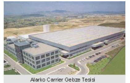
Alarko Carrier Gebze Tesisi
