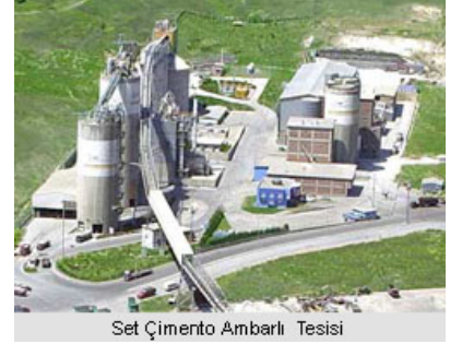
Set Çimento Ambarlı Tesisi
